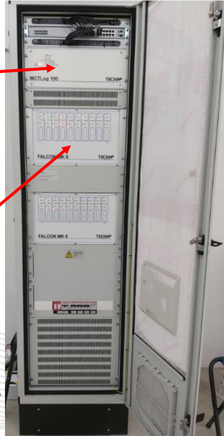
Falcon MKII – para 2 entradas de sensor UWB DP + 2 entradas de sensor ultrasónico
