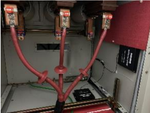
Cable de interruptor / brazo de interruptor
