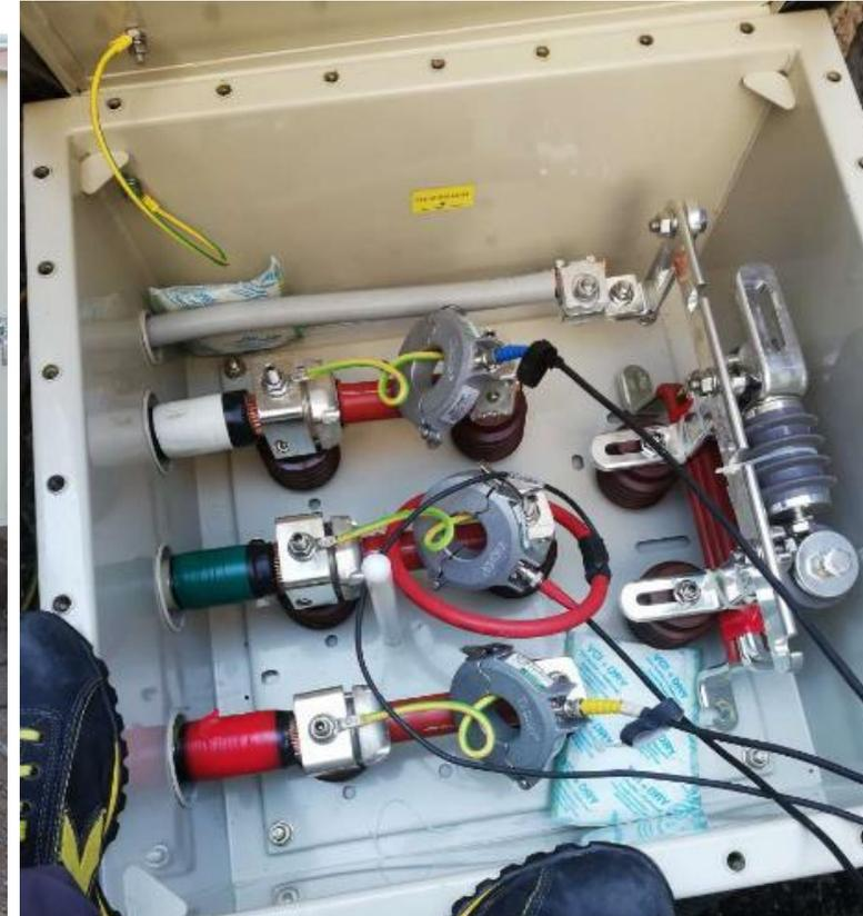
Los transformadores de corriente de alta frecuencia se utilizan ampliamente durante la puesta en marcha de cables HV. Al colocar el sensor tipo pinza (de núcleo abierto) alrededor de los cables de tierra de la terminación/junta, es posible detectar la forma de amplitud y la polaridad de los pulsos de descarga parcial que fluyen en la cubierta del cable.
